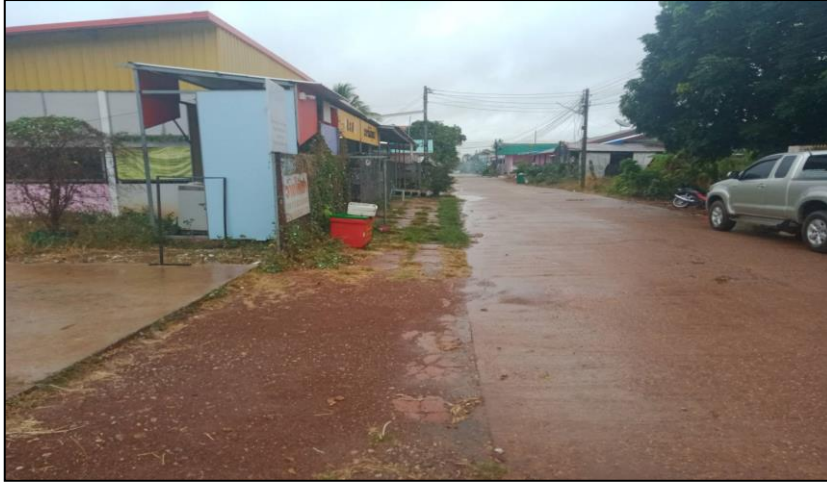
ภาพก่อนดำเนินการ
