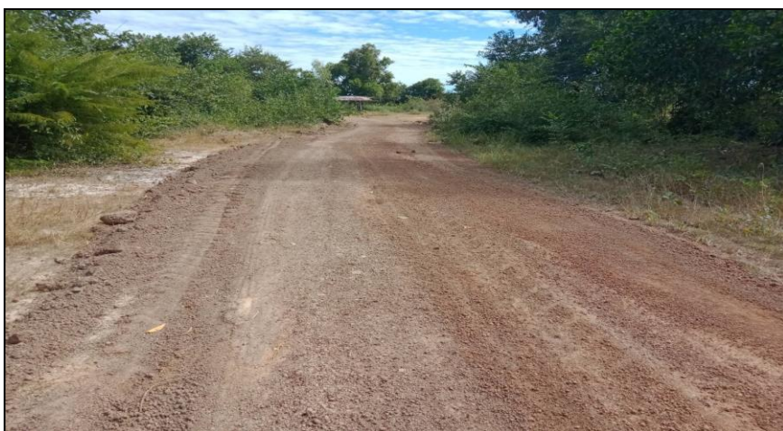
ภาพดำเนินการแล้วเสร็จ หมู่ ๑๑.
