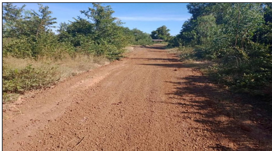
ภาพดำเนินการแล้วเสร็จ หมู่ ๔.
