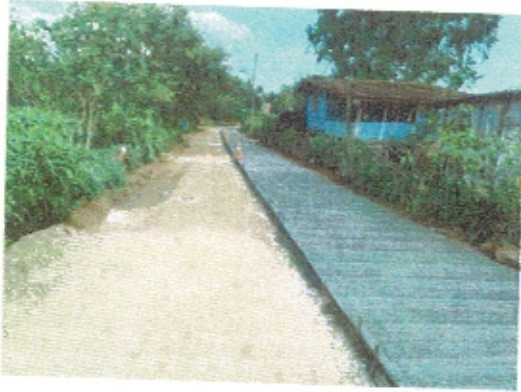
โครงการก่อสร้างถนน คสล. ถนนศรีสำราญ บ้านนาเหมืองน้อย หมู่ที่ ๑๓
